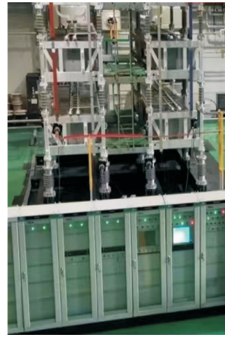
图 1 柔直换流阀功率模块实物图
